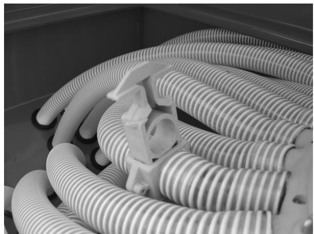
Рис. 34. Механический клапан установлен на распределителе
