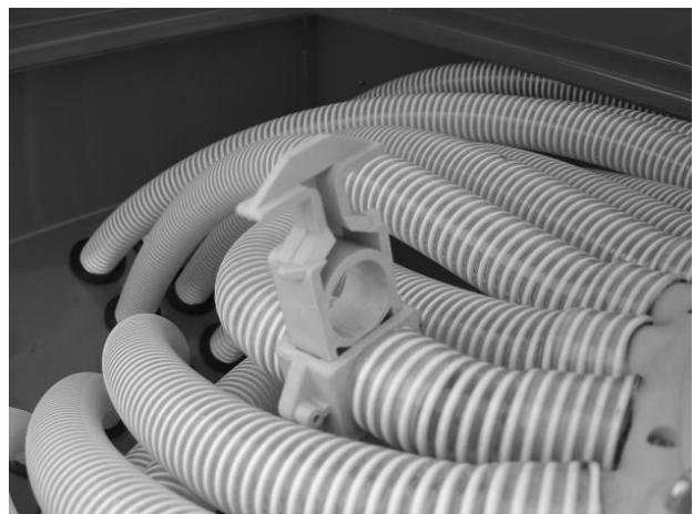
**Fig. 34** clapet mécanique monté sur le distributeur
